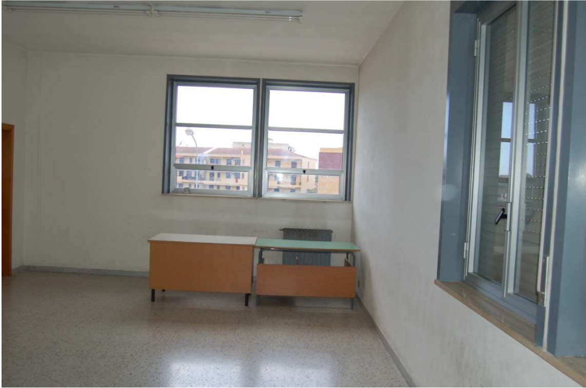
Foto n° 18 infissi in alluminio anodizzato esistenti
