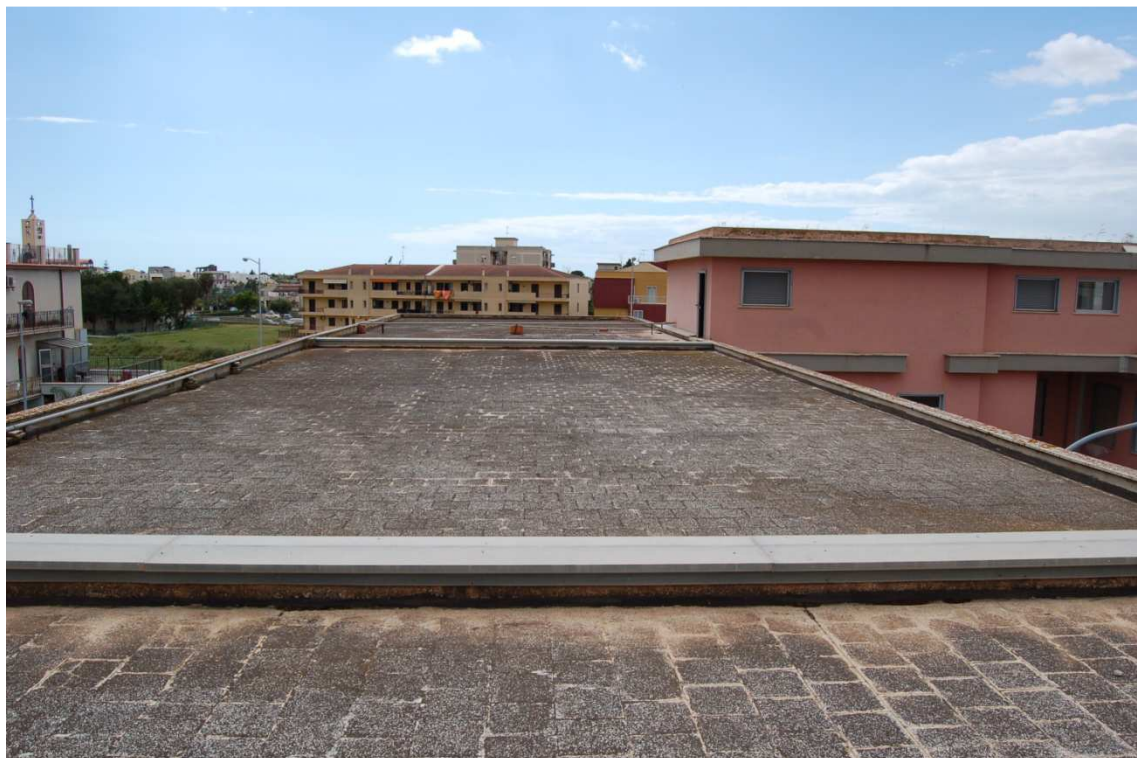
Foto n° 4 parte della copertura dove verranno collocati i pannelli fotovoltaici
