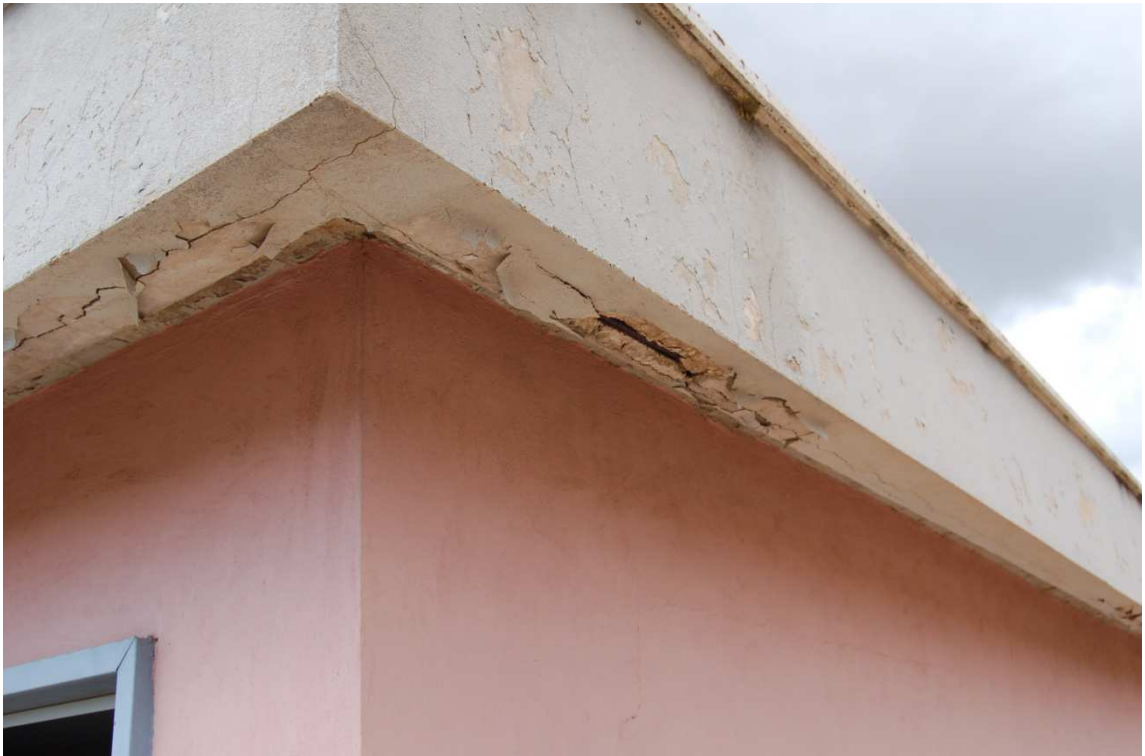
Foto n° 3 ammaloramento cornicioni
